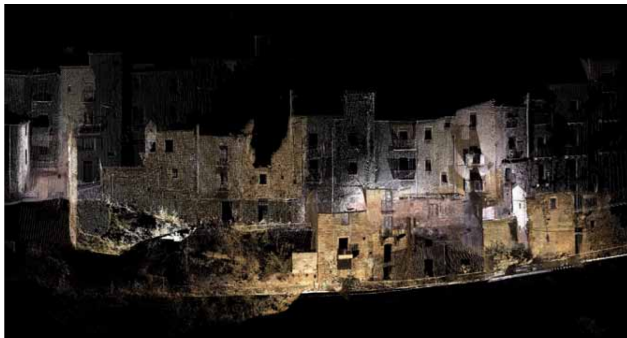
Elaborazione del rilievo Laser Scanner 3D
